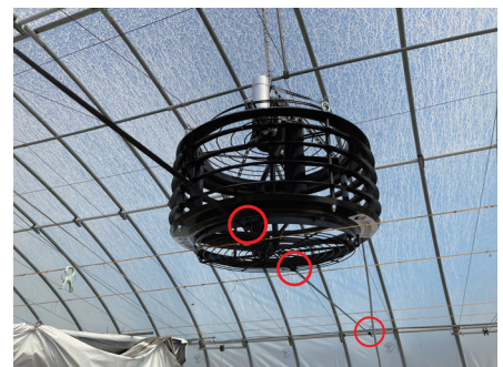
一点吊りでは動作中に回転してしまうため横からエスター線やマイカー線などでエリターボを固定します。
