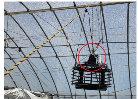
ロープでエリターボを吊り上げている様子
